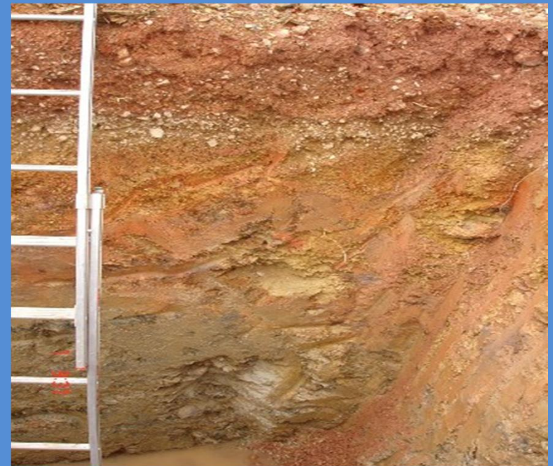
ABERTURA DE TRINCHEIRAS
